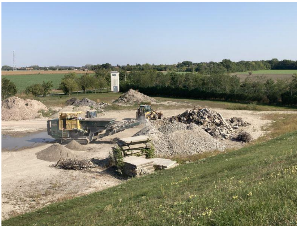
Obrázok 26 – Drvenie stavebného odpadu na skládke Čukárska Paka
