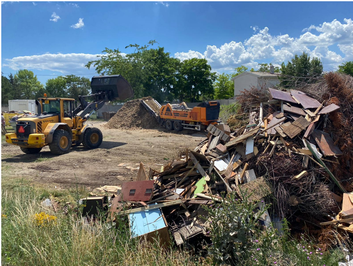
Obr. č.19 Štiepkovanie dreveného odpadu
