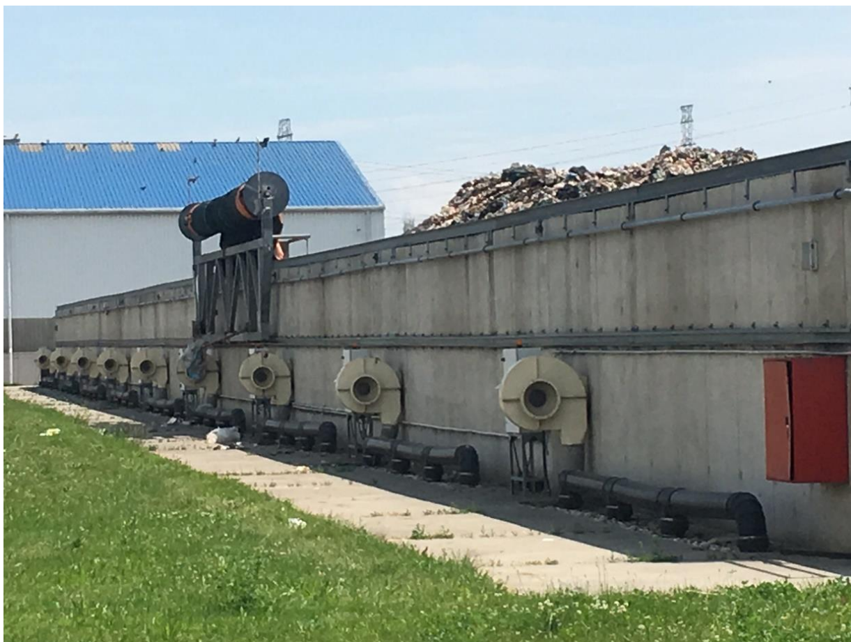
Obr. č. 28 Linka na mechanicko – biologickú úpravu odpadu v Maďarsku, biologická stabilizácia frakcie, GYŐRSZOL Zrt., Győr
